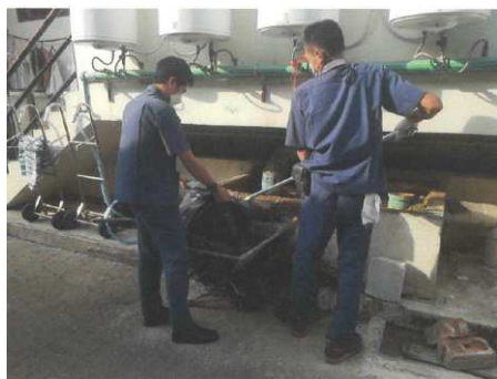
ภาพที่ 1-3 บ่อดักไขมัน และการดักไขมันของโครงการฯ
